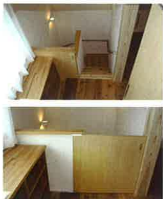
階段には転落防止用の柵を設置。
